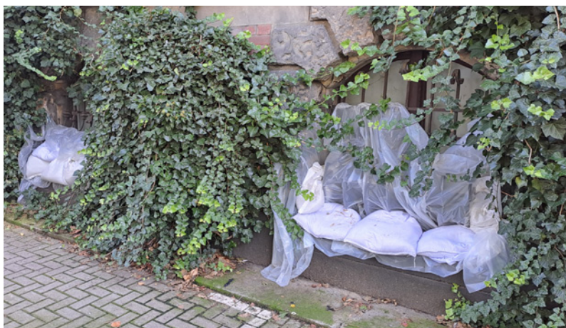
Il. 1. Pozostałości po zabezpieczeniach przeciwpowodziowych już po ustaniu zagrożenia, Muzeum Narodowe we Wrocławiu, fot. NIM
