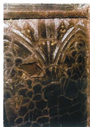
Fragment witraża na ścianie północnej przed rozpoczęciem prac
