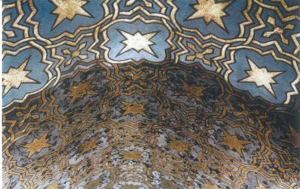
Fragment sklepienia prezbiterium podczas oczyszczania
