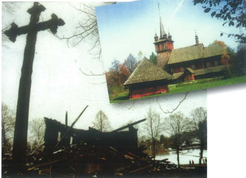
▲ Zgliszcza kościółka w Woli Justowskiej, który spłonął 7 kwietnia 2002 r. Powyżej stan przed pożarem.
