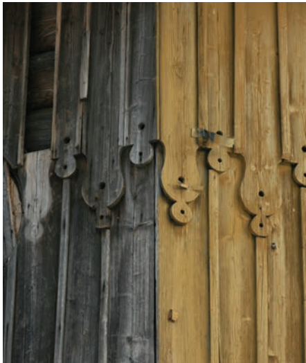
Pierwotny szalunek ścian dawnego kościołka
