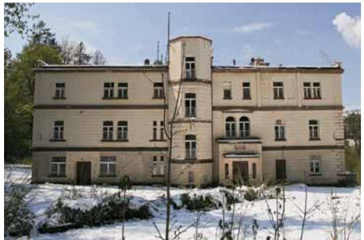
Rezydencja barona von Zedlitz und Neukirch w Zagórzcu Śląskim. Fot. archiwum autora
