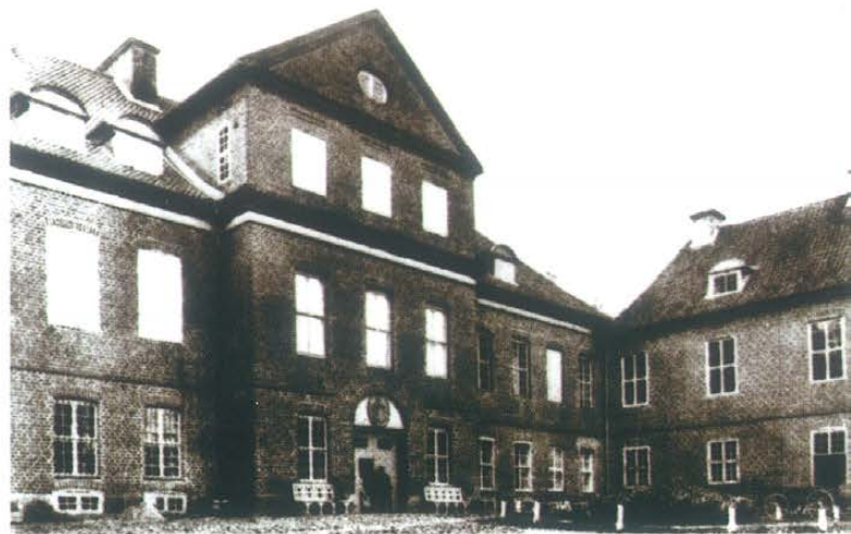
Pałac w Karwinach, elewacja frontowa, ok. 1910 r.
