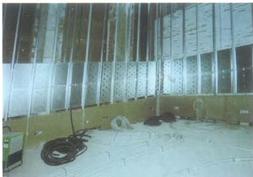
▲ Montaż czujek pojemnościowych w trakcie remontu Galerii
