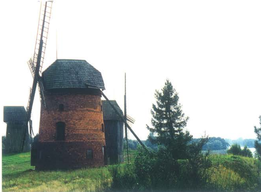
▲ Tylko indywidualne rozwiązania instalacji odgromowych umożliwiają demonstrację działania budynków przemysłowych. WPE w Diekanowicach. Fot. autor
