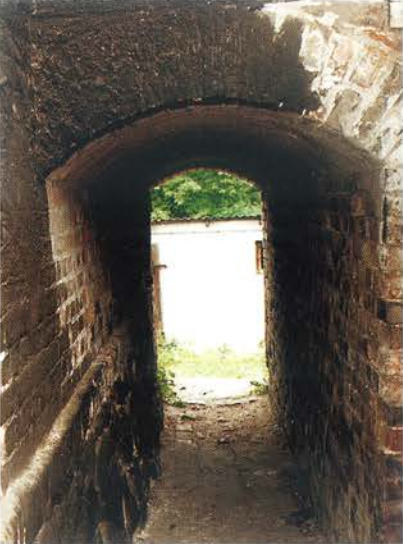
▲ Przejście między budynkami czworoboku folwarcznego.
