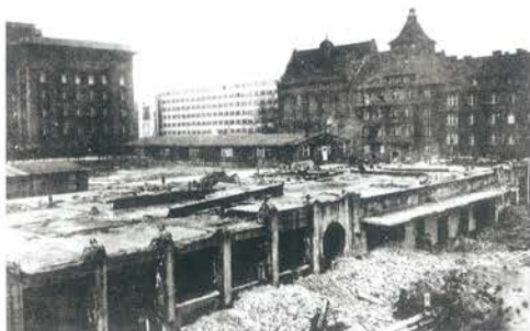
▲ Gmach Muzeum Śląskiego w trakcie rozbiórki przez Niemców. Fot. ze zbiorów MŚK
