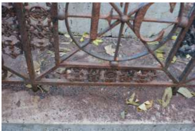
Fot. 4-8. Cmentarz Père-Lachaise; grób Chopina; uszkodzenia elementów kamiennych i metalowych, m.in. widoczne zniszczenie kotwy ogrodzenia na skutek przemieszczania się muru oporowego.
