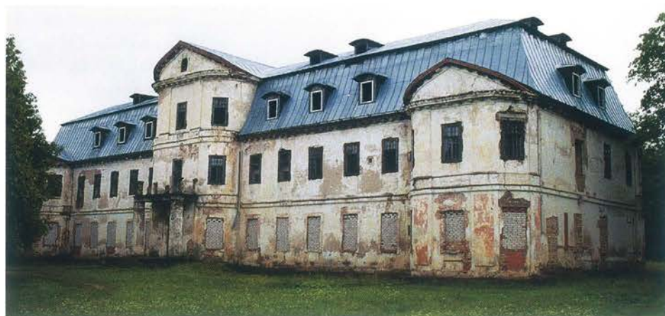
Pałac Platerów, 1791. Fot. autor
