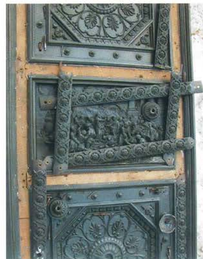
Drzwi Kaplicy Pałacu w Wilanowie, fragment, prace demontażowe
