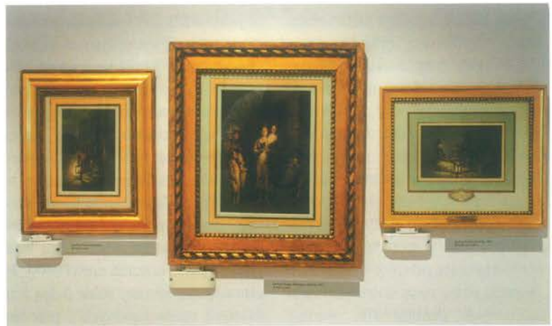
Sposób montażu urządzeń może decydować czy zabezpieczenia elektroniczne spełnią swoją rolę, czy będą tylko atrapa, tak jak w tym przypadku (a wystarczyłoby tylko inaczej zamontować czujki)
