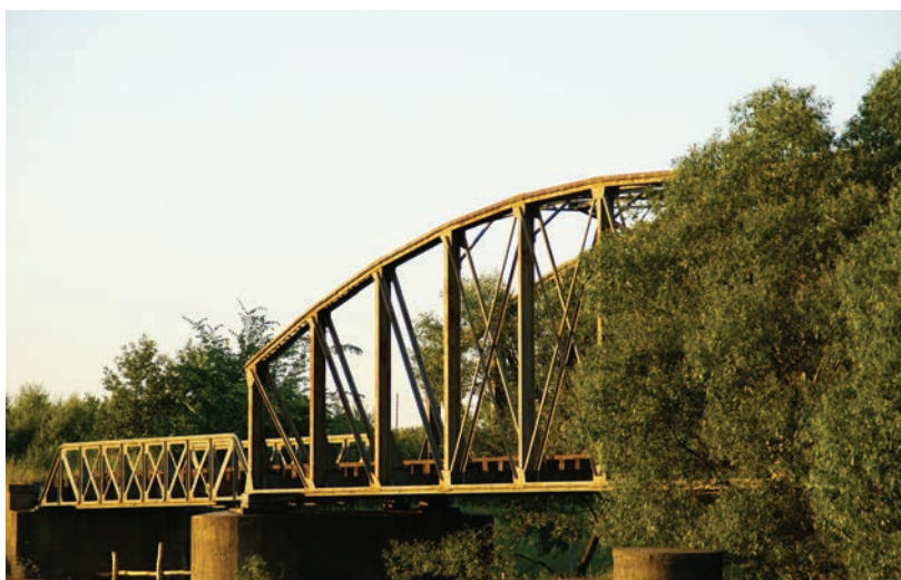
Most kratownicowy we wsi Żarowo, zbudowany w 1894 r.
