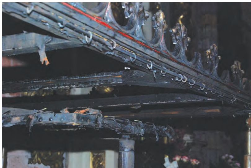
Z baldachimów pozostała jedynie uszkodzona przez ogień konstrukcja. Fot. Piotr Ogrodzki
