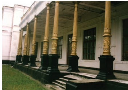
Szpoła - pałac hr. Urusowej. Fot. autor
