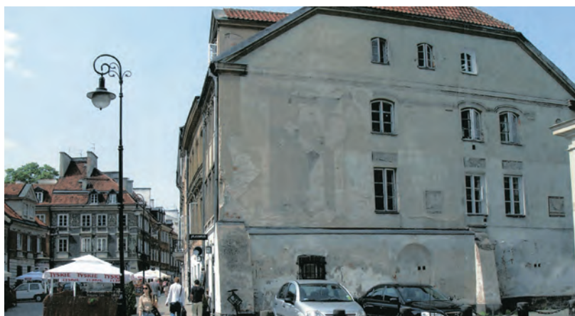
Fresk przy ul. Freta. Stan aktualny. Fot. autor
