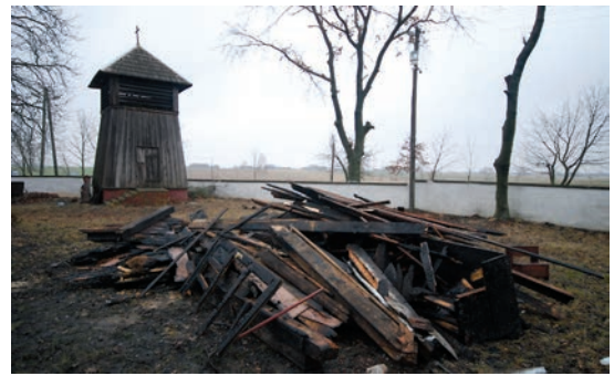
2. Po pożarze. Stojącą w obrębie kościoła zabytkową dzwonnice udało się ocalić od zniszczenia
