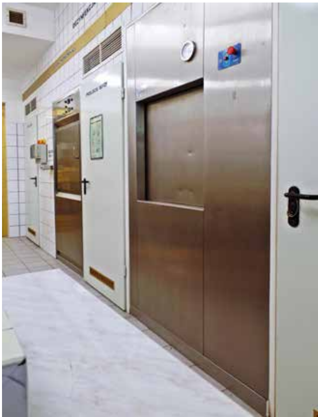
Biblioteka Narodowa, Instytut Konserwacji Zbiorów Bibliotecznych – na pierwszym planie komora do dezynfekcji, na drugim komora do przewietrzania, fot. Jakub Piechal
