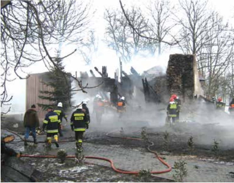
Pożar zniszczył całkowicie drewnianą część kościoła, pozostała jedynie murowana zakrystia. Fot. WKZ Piotrków Trybunalski
