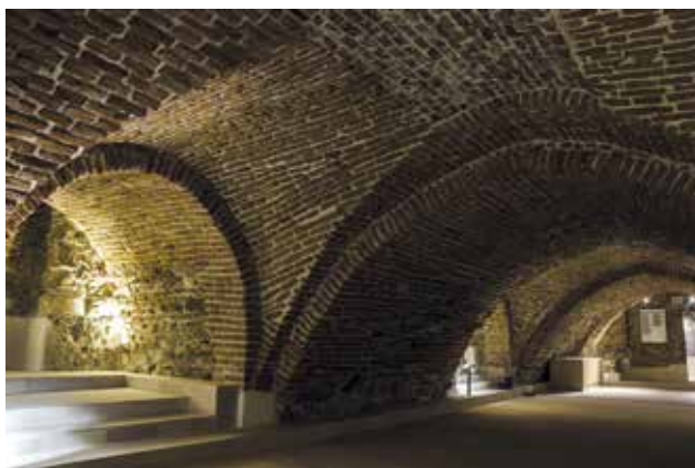
Wejście do bocznej krypty numer 8, widok od strony krypty centralnej, stan po zakończeniu prac remontowych, fot. J. Bachta
