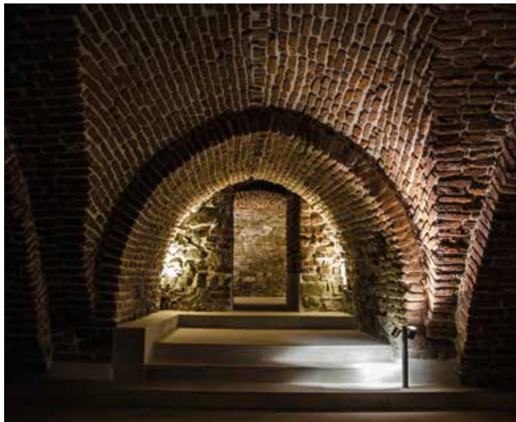
Wejście do bocznej krypty numer 7, widok od strony krypty centralnej, stan po zakończeniu prac remontowych, fot. J. Bacht
