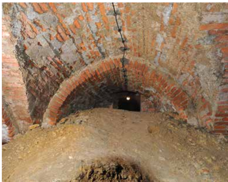
Wejście do bocznej krypty numer 7, widok od strony krypty centralnej, stan przed podjęciem badań archeologicznych i prac remontowych, fot. J. Bacht
