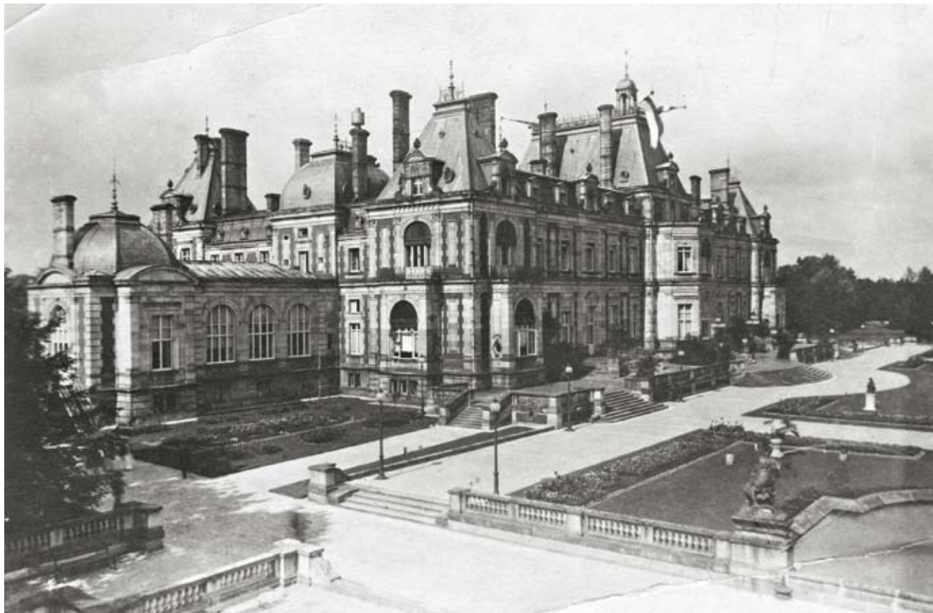
Neorenesansowy pałac rodziny Donnersmarck w Świerkłańcu, zniszczony w 1945 r. Fot. NAC
