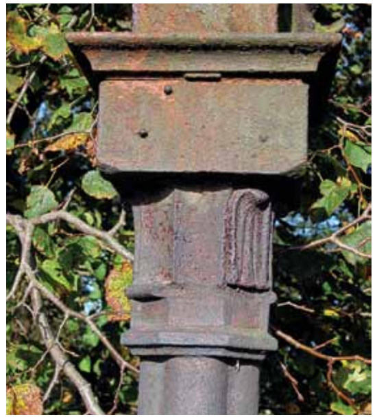
Fragmety zwieńczenia kaplicy przechowywane w magazynie nadleśnictwa po zniszczeniu połączeń śrubowych na skutek rozwoju procesów korozyjnych.
