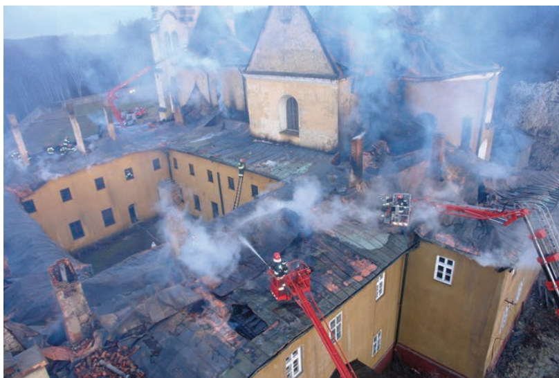
Alwernia. Pokrycie dachowe blachą uniemożliwiło dostęp do więzby, która uległa wypaleniu. Fot. Komenda Powiatowa PSP w Chrzanowie
