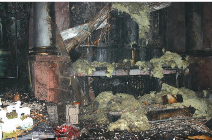
Miejska Górka. Szopka bożonarodzeniowa. Zwarcie w instalacji elektrycznej spowodowało pożar. Fot. Komenda Powiatowa PSP w Rawiczu
