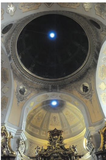
Alwernia. W wyniku pożaru uszkodzeniu uległa kopuła nad transeptem kościoła. Fot. P. Ogródzki
